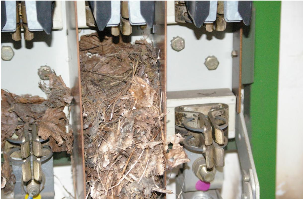
Abbildung 10: Nest, nicht aktiv genutzt, in einer Stromschalt-Einheit (Aufnahme 09.02.2019)
